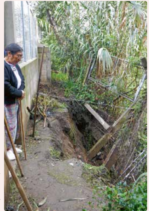
Catarina S. sieht mit Schrecken, wie nah die Abbruchkante schon der Grundstücksmauer gekommen ist.
